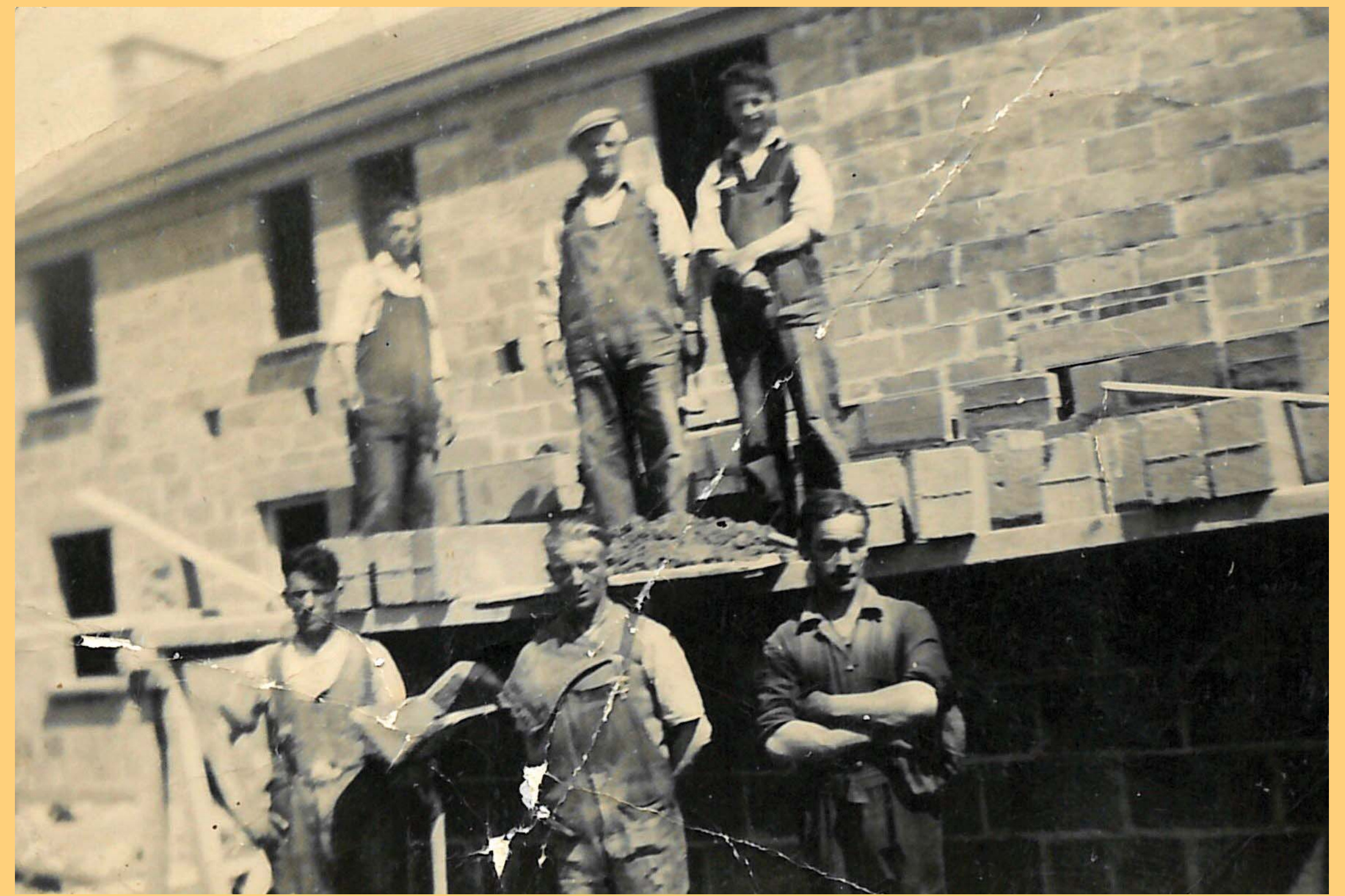
Building local authority housing in Dundalk, 1950 (Louth County Archives) Ag tógáil tithé údaráis áitiúil i nDún Dealgan, 1950 (Cartlanna Chontae Lú)
